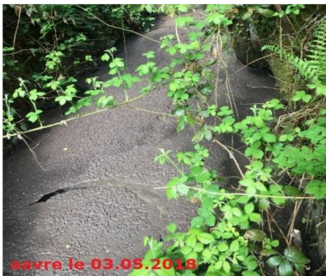
10) 03.05.2018 BOUES D'EPURATION SORTIE 2 ème BUSE FORÊT de TRAPPES
