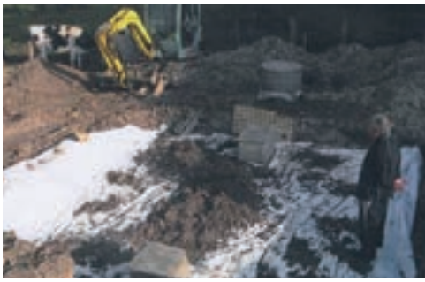
Le chantier remue beaucoup de terre
