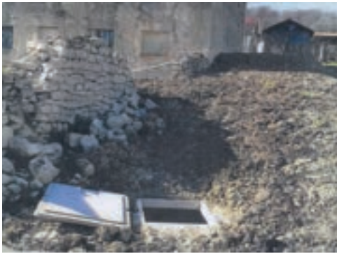
In fine, ce regard sera la seule trace visible de l'installation enterrée.
