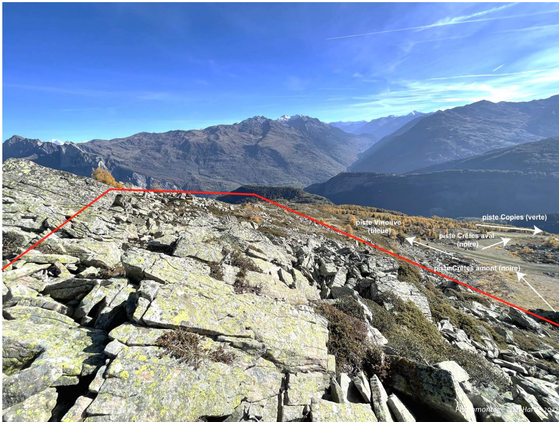
Vue n°5 : vers la fin du terrassement n°2
