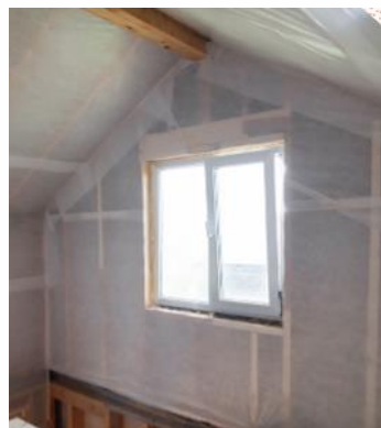
Photo : Frein-vapeur correctement posé
