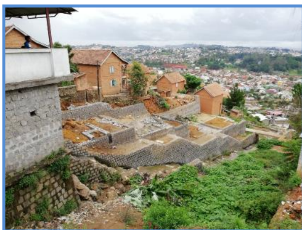
Fondation des quatre nouveaux logements sur un mur de soutènement
