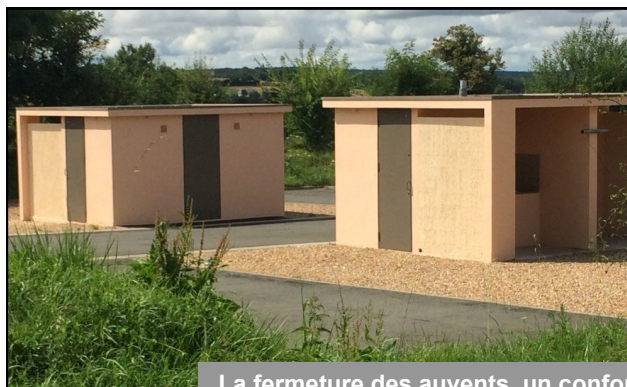
La fermeture des auvents, un confort supplémentaires pour les usagers.
