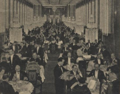
* C'est dans ce grand salon, représenté ici le jour de l'inauguration officielle de Normandie, le 23 mai 1935, que s'est déclaré l'incendie. (Ph. P.P.W. 28.286.)
