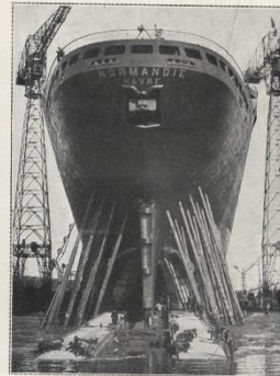
Les ouvriers achèvent le suiffage des glissières.
