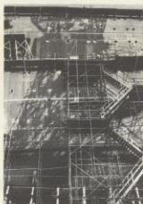
Pose des trois derniers éléments d'étrave respectivement de 59 Tonnes, 27 Tonnes et 31 Tonnes. Il a fallu 17 minutes et 10 hommes pour mettre en place le dernier élément.
