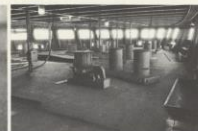
Pont de manœuvre arrière, cabestans et chaudrons sont déjà en place.
