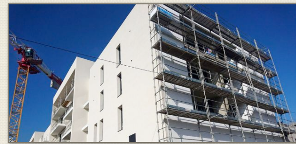
Construction de logements, ici à Bourgoin-Jallieu en février 2017 (ALLILI MOURAD/SIPA)
