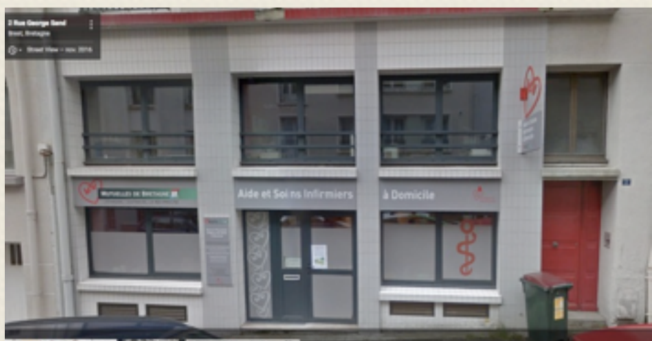
Le bâtiment situé 2, rue George Sand, à Brest
