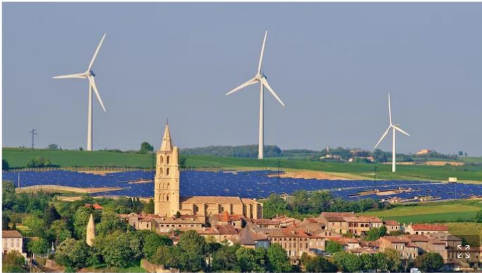
Le chantier du parc éolien et photovoltaïque d'Avignonet-Lauragais, (Haute-Garonne). Crédit : Raphaël HELLE/SIGNATURES
