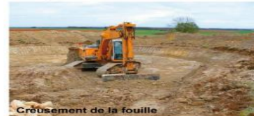
Créusement de la fouille
