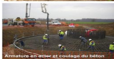
Armature en acier et coulage du béton
