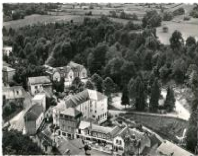
Fig. 7 - Photographie aérienne réalisée entre 1957 et 1960 montrant le casino à l'arrière- plan. Lapie (éditeur) - photographie, carte postale - Archives départementales des Hautes-Pyrénées, Tarbes - 5 Fi 127/20 - Auteur : Baglin, Géraldine (reproduction)
