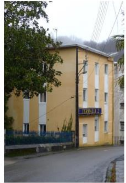
Fig. 6 - Vue générale de la Résidence Termalia 2 (du côté de la rue de Provence). Auteur : Baglin, Géraldine
