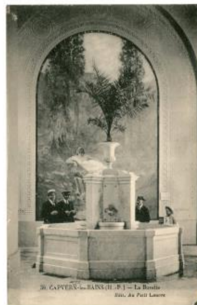
Fig. 15 - La buvette située dans le pavillon. Au Petit Louvre (éditeur) - photographie ; carte postale - Archives départementales des Hautes-Pyrénées - 5 Fi 127/148 - Auteur : Baglin, Géraldine (reproduction)
