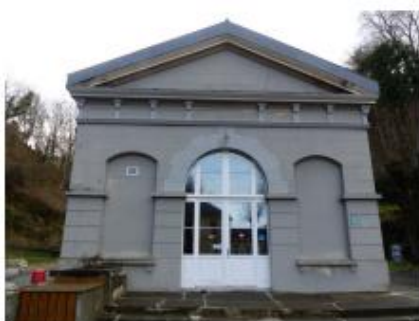
Fig. 28 - Pignon nord de l'édifice. Auteur : Baglin, Géraldine
