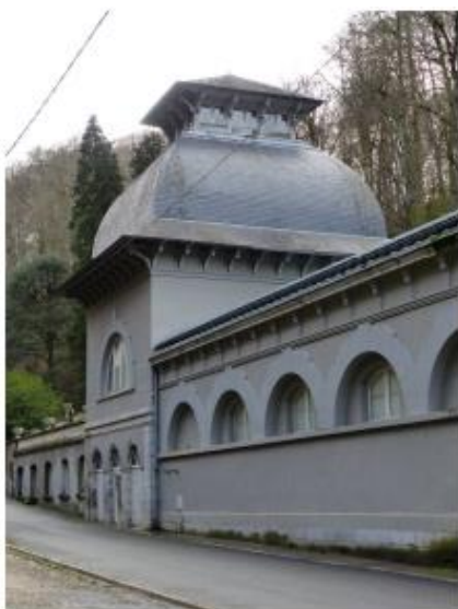
Fig. 25 - La buvette-promenoir, vue depuis le nord-est. Auteur : Baglin, Géraldine
