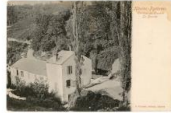
Fig. 12 - L'établissement dans les années 1900. Villatte A. (éditeur) - photographie ; carte postale - Archives départementales des Hautes-Pyrénées - 5 Fi 127/91 - Auteur : Baglin, Géraldine (reproduction)
