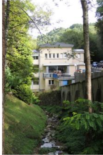
Fig. 20 - Vue des thermes depuis l'est (ruisseau Laca). Auteur : Fourcayran, Marion
