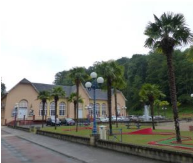
Fig. 5 - Vue depuis le nord-est.
