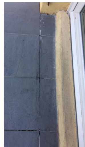
Dégradation des joints de carrelage liée à une insuffisance de pente (Crédit photo : Eurisk)
