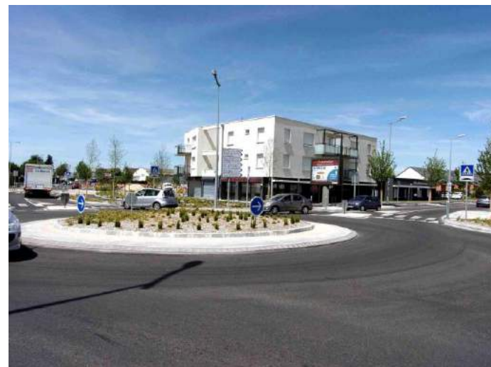
Exemple d'aménagement récent - Giratoire à l'intersection des routes de Puits Berteau et rue du Mouton
