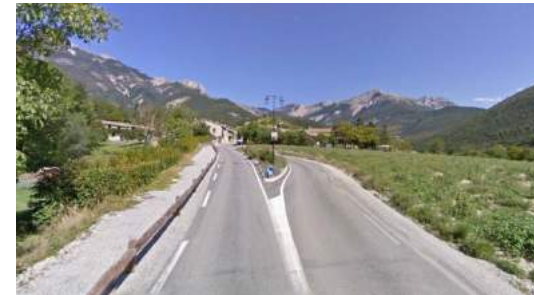
Ilot central en entrée de village
