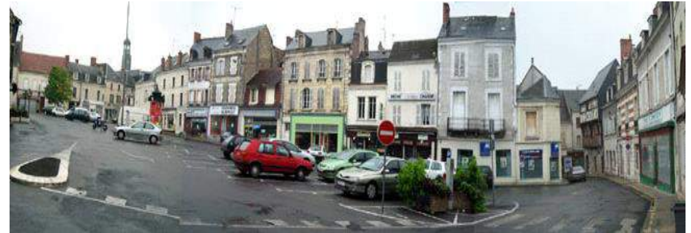
Place Vaillant Couturier avant travaux - photo 2011
