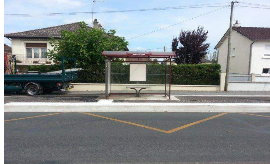
Exemple d'adaptation d'un quai de bus et mise en conformité PMR
