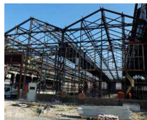
Lors des travaux de réhabilitation pour l'installation du bowling en 2014-2015
