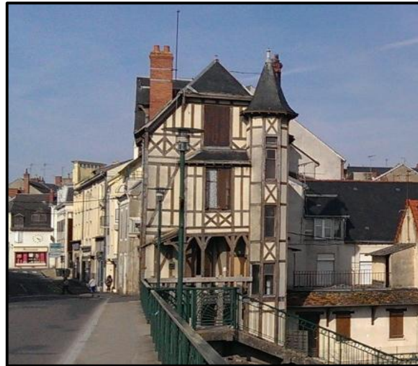
FIGURE 34: PHOTO DE LA MAISON SUR LE PONT TRAVERSANT LE CHER - CREDIT PHOTO: DIMITRI LETOURNEAU
