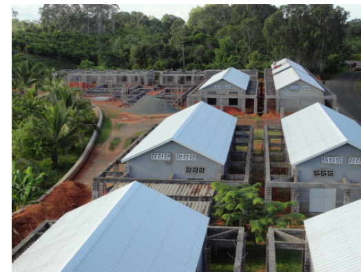
Les bâtiments sont presque achevés
