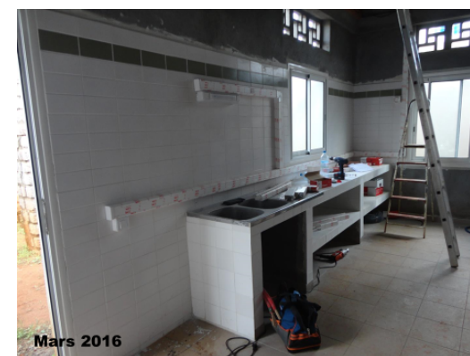
Installation de l'électricité à la pharmacie
