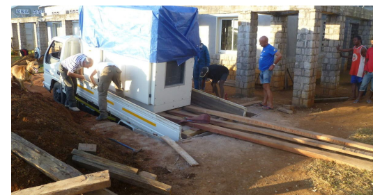
Mise en place d'un des deux groupes électrogènes.
