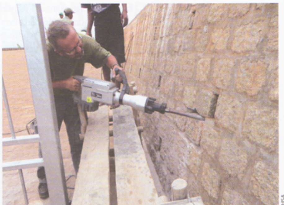
Le chantier est tellement vaste qu'il faut se déplacer pour entendre le bruit des outils.
