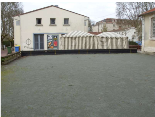
2011.02.27 SAINTES BOULODROME Dégradations
