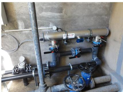
Le Bassin d'eau potable de Montblanc bas a été équipé d'un stérilisateur Ultra Violet . L'alimentation électrique du bassin a été réalisée par le Syndicat d'Energie 04 qui a profité du chantier pour éliminer la bretelle aérienne qui alimentait le bâtiment communal. C'est la société SEREX qui a posé le stérilisateur et le compteur de production. Tous les bassins de la commune sont maintenant équipés . Nous remercions le SDE 04 pour la réalisation de ce chantier.. Le coût
