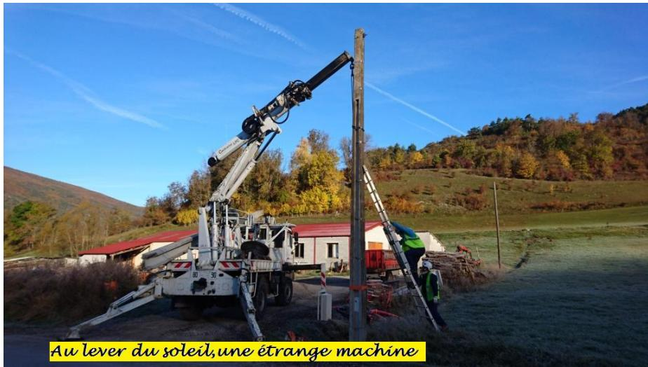
Les câbles EDF souterrains ayant été raccordés, et les anciens aériens récupérés, ce sont 2 poteaux en béton et 1 poteau en bois qui ont pu être supprimés le long de la D52 à l'entrée du village.
