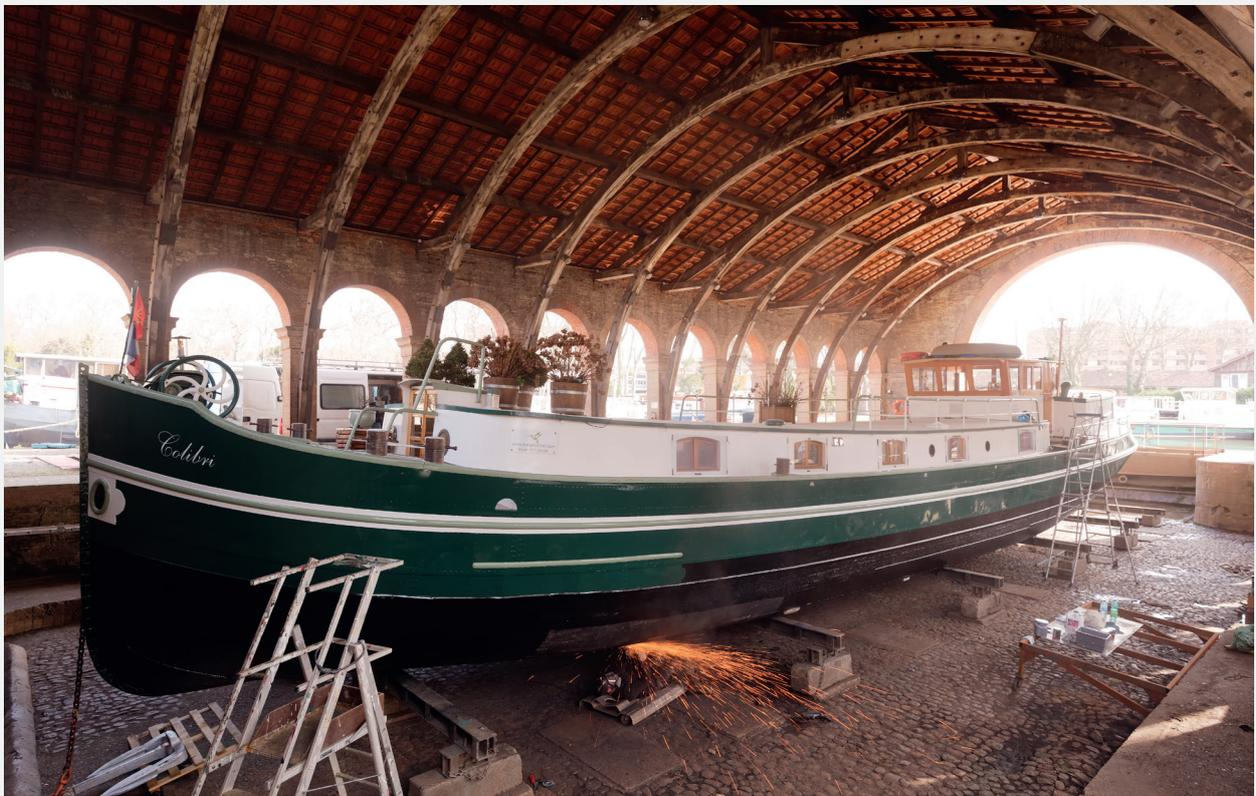
**C**onçu au milieu du XIX<sup>e</sup> siècle, le site du Pont-des Demoiselles est installé à proximité du nouveau port Saint-Sauveur. Raccordé au canal du Midi, il comprend un bassin central qui desservait quatre bassins de radoub, destinés à réparer les bateaux en cale sèche. L'une des trois formes subsistantes a été couverte d'une charpente d'une grande technicité, l'un des plus beaux exemples d'architecture fluviale à Toulouse.
