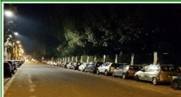
Expérimentés depuis un an dans les rues St Luc et Georges Picot, les lampes SHP (150 W et 9000 Lumens) ont été remplacées par des lampes LED (100 W pour 11 000 Lumens) donc plus puissantes et moins gourmandes. L'éclairage maxi est piloté par des détecteurs de passage de véhicule ou de piéton.
