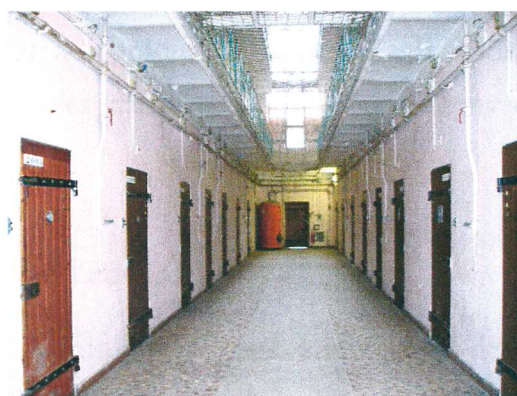
Ci-dessous : vue de l'aile est, couloir central et plafond.
