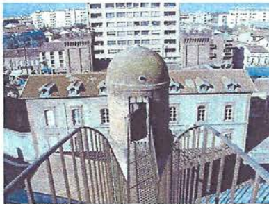
Vue prise de la Coupole du « beffroi »
