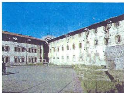
Vue intérieure de la Maison d'Arrêt entre deux branches de l'étoile
