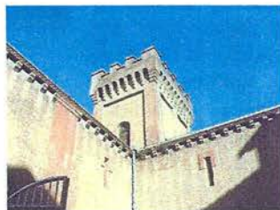
Vue intérieure du « Castelet » en façade de la Maison d'Arrêt
