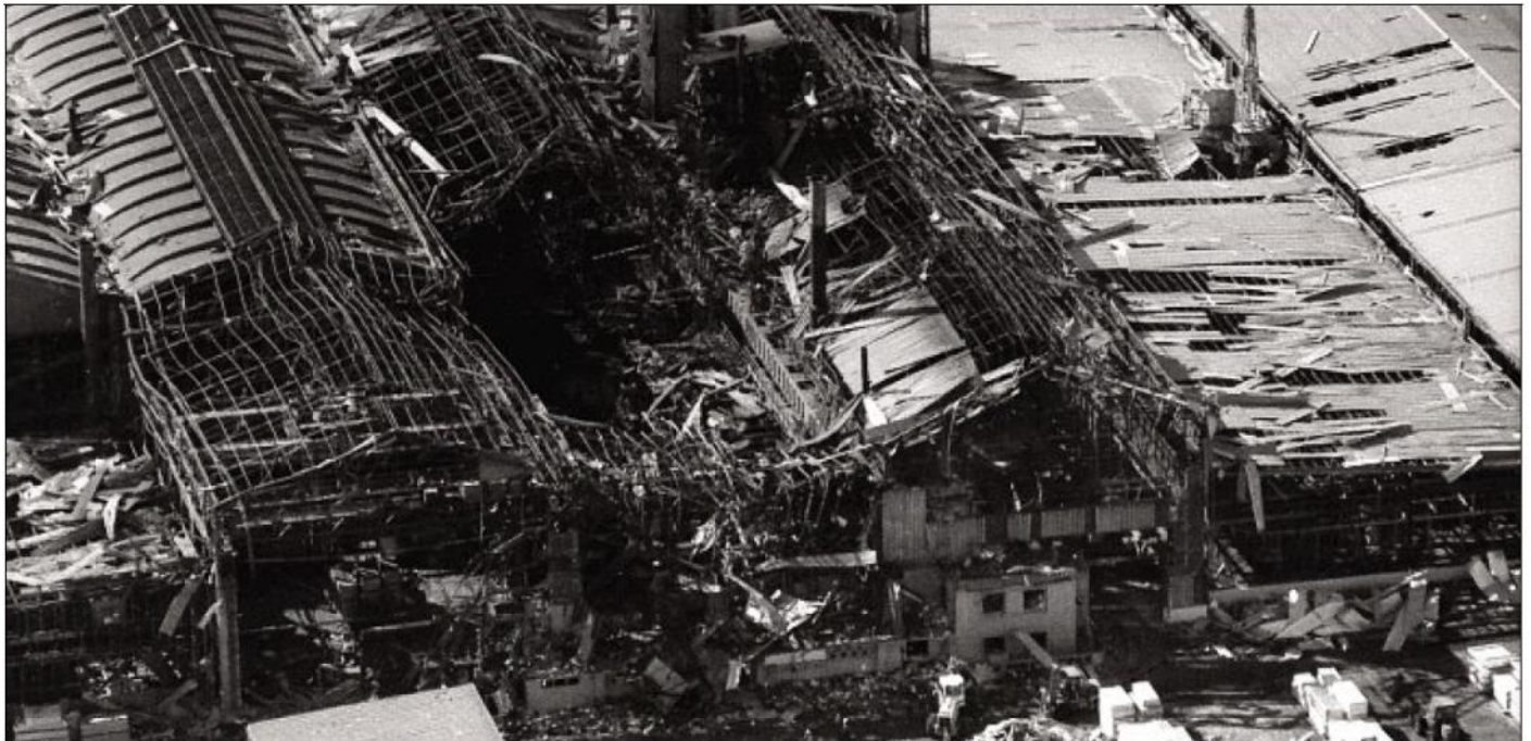
CATASTROPHE. La fonderie un jour après l'explosion. Trois de ses huit fours étaient alors complètement détruits. Moins de sept semaines après, grâce à la mobilisation de nombreux employés, l'usine retrouvait un fonctionnement presque normal. ARCHIVES LA MONTAGNE
