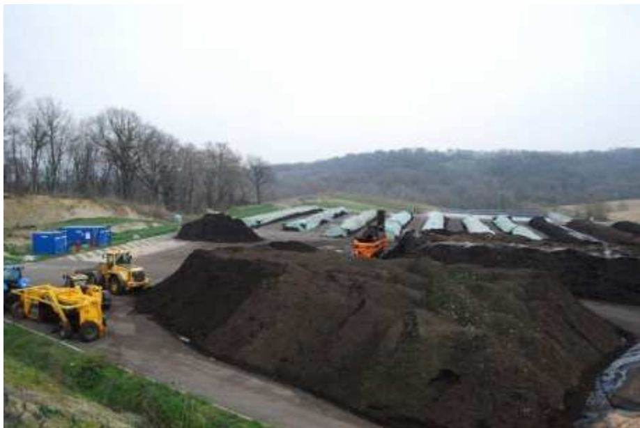
[LEG_LEGENDE]Plate-forme de transformation des boues des stations d'épuration, joliment dénommée Terre des Gaves. © Photo
