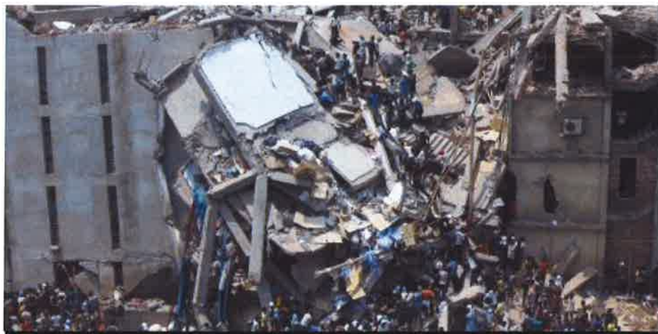
Le 24 avril 2013, l'effondrement du toit d'un immeuble abritant des ateliers de confection textile a provoqué la mort de 1133 personnes. (Crédits : Reuters)
