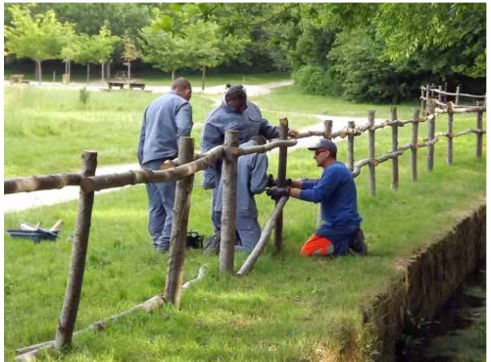
Pose de barrières le long du canal du Noiron (Rivoli) par l'un des chantiers du service municipal d'insertion.
