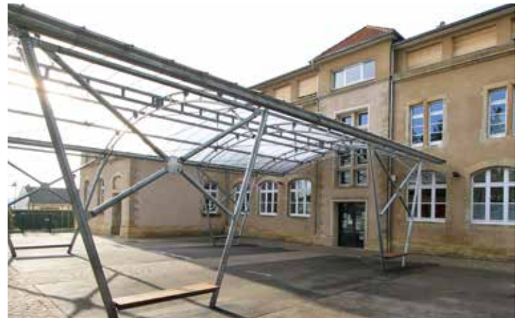
Rénovation de l'école du Centre et création d'un préau.
