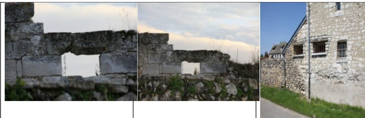
Effet miroir imposé vis-à-vis des ouvertures du mur à contreforts.
