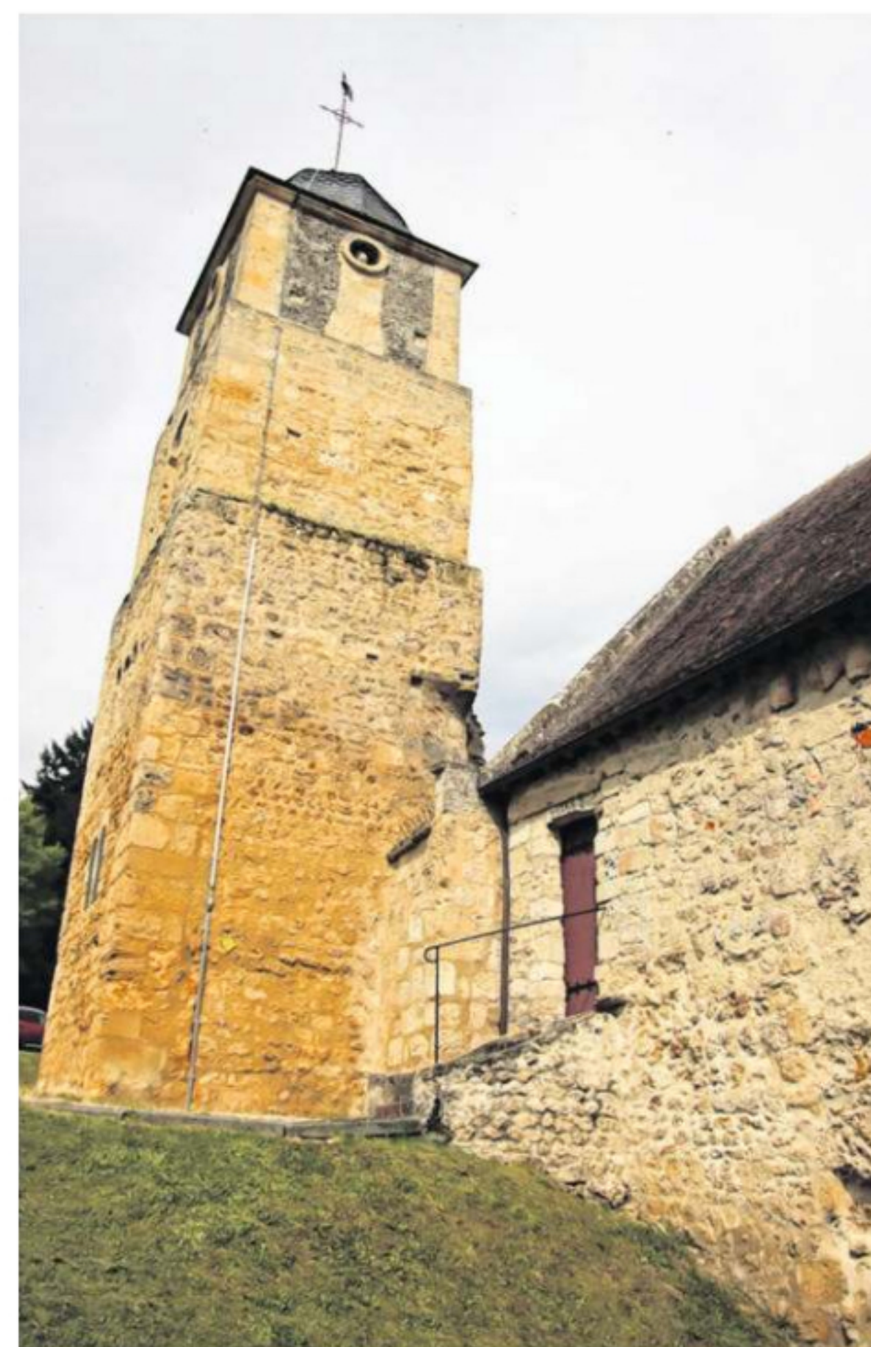
Bien que partiellement en ruines, l'église souligne deux époques architecturales : romane et gothique.
