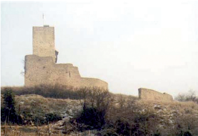
Le Wineck-Katzenthal, exemple de château à « chemise »
