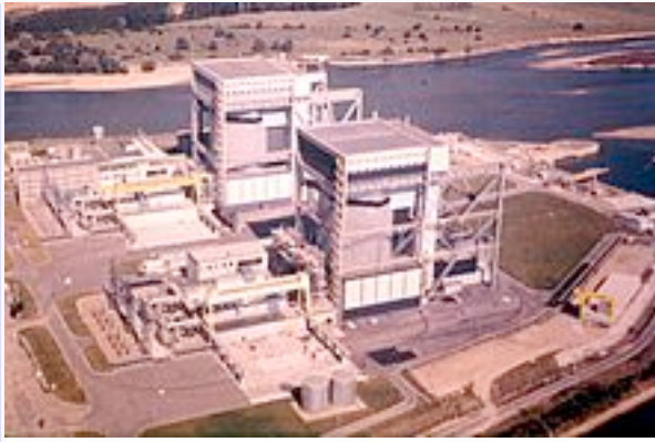
Vue de la centrale de Saint-Laurent-des-Eaux (Loire et Cher).
