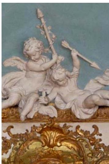
Le stuc, dont nous avons vu des exemples avec l'Hôtel de Soubise, est très utilisé au XVIIIème siècle. Il s'agit d'un matériau formé de chaux éteinte, d'eau et de plâtre, de la poudre de marbre peut y être ajoutée. Cette pâte onctueuse qui se solidifie rapidement permet de décorer des membrures architectoniques, des murs et des plafonds.
