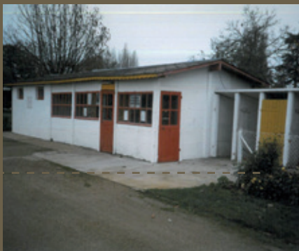
1999 - le bâtiment existant a été rasé et reconstruit
