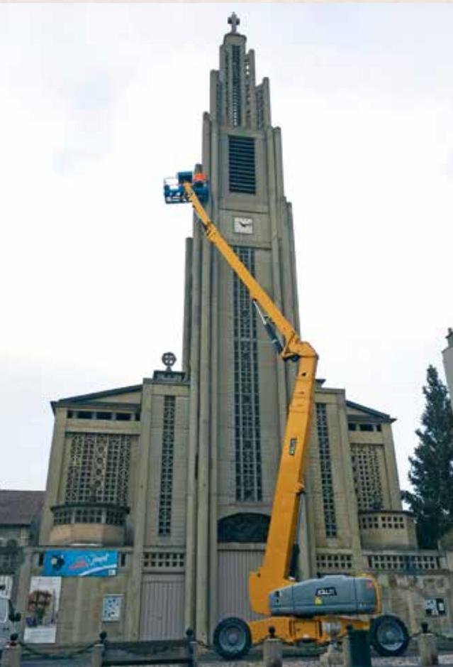
Travaux de diagnostic de l'état de dégradation du béton du clocher de ND du Raincy novembre 2019
