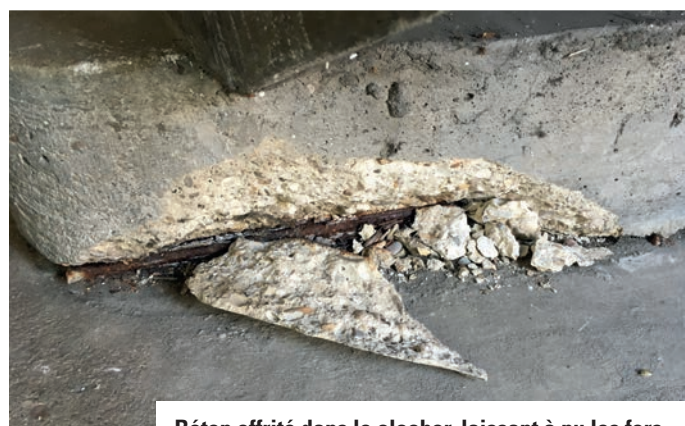
Béton effrité dans le clocher, laissant à nu les fers.
