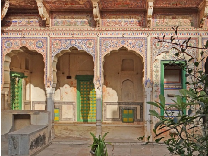
Cour intérieure d'une Haveli en Inde (XVIIIe siècle)
