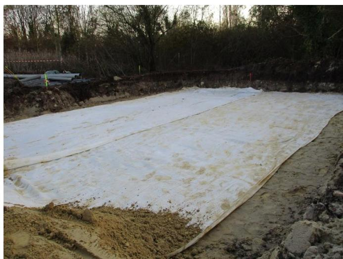
Figure 2. La pose des géogrilles © SvdB
