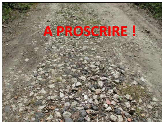
Comblement des ornières avec des déchets de BTP, bois de Footel.
