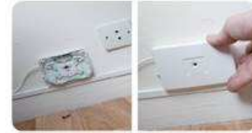
PRISE TERMINALE OPTIQUE (PTO) RACCORDEMENT FINAL
