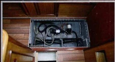
Les planchers ont été recouverts d'un lino imitation bois plutôt efficace en termes d'esthétique. Lorsqu'on les soulève, on trouve les réseaux d'eau sous pression et pompes de cales, très proprement installés, dans des cales parfaitement propres.
