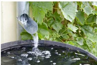
L'installation de récupération des eaux de pluie pour un usage autorisé doit être entretenue et, si elle l'est à l'intérieur du logement, les canalisations et robinets vérifiés 2 fois par an. *Attention aux moustiques*
